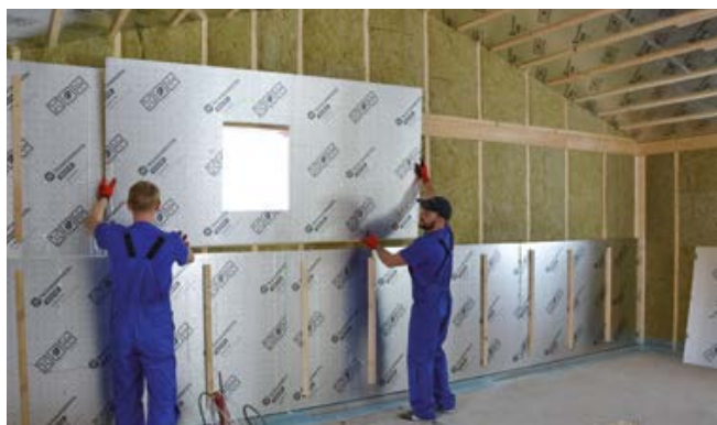
Внутреннее утепление стен
